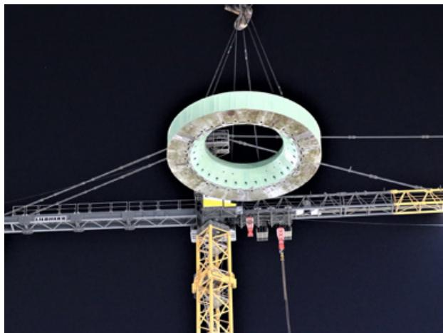
перед установкой корпуса реактора смонтировано опорное кольцо, на которое приходится основная нагрузка корпуса. Спустя неделю был смонтирован третий ярус внутренней защитной оболочки реакторного здания. После сборки качество сварных соединений было подтверждено ультразвуковым методом.
