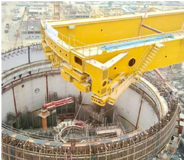
В августе на блоке № 1 был завершен монтаж металлоконструкций купола внутренней защитной оболочки реакторного здания. Общая масса конструкций — 230 тонн. На блоке № 2 в июне — раньше установленного планом срока — завершили бетонирование четвертого яруса внутренней защитной оболочки — до уровня 38,5 м. В настоящее время строители возводят пятый ярус, поднимая второй блок до уровня 44,1 м.
