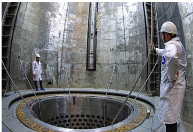
Na segunda unidade de energia são realizados trabalhos de partida e ajuste. Em breve, de acordo com o cronograma, estão previstos ensaios hidráulicos e lavagem circulatória dos sistemas e equipamentos do primeiro e segundo circuitos da instalação do reator. O carregamento com combustível do reator está previsto para o terceiro trimestre. Para o quarto trimestre é planejada a ligação na rede.
